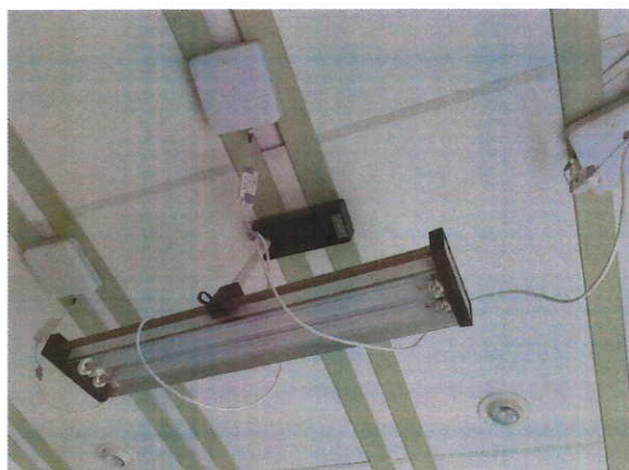
Fot. 1. Zestaw badanych lamp, zainstalowanych przy suficie, wykorzystywanych do oceny redukcji obciążenia mikrobiologicznego powietrza
